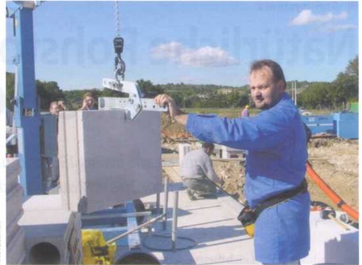
Vario-Wechselbacken sind speziell für die Aufnahme von Porenbetonsteinen konstruiert worden.
