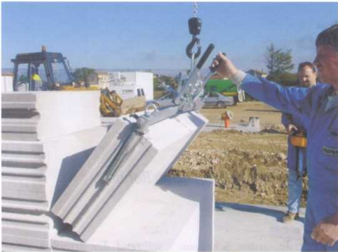
Den sog. Vario-Steingreifer gibt es als Bolzengreifer oder wie hier als Außengreifer.
