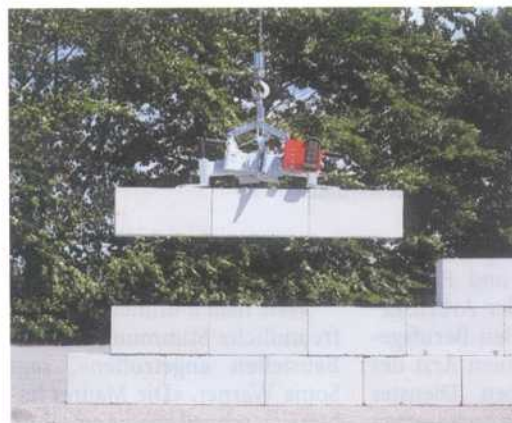
Bei der Multi-zange lässt sich die Greifweite mit einem Handrad verstellen.
