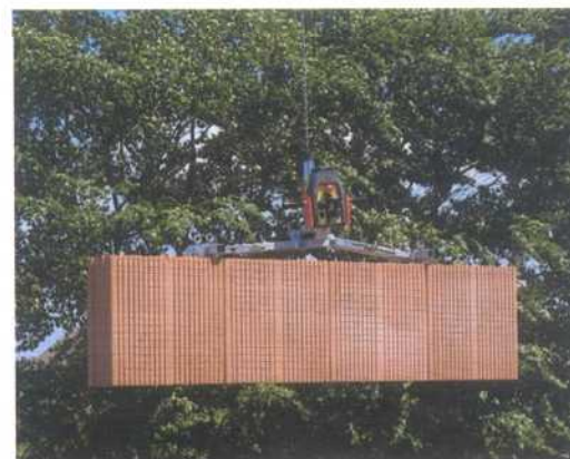
Gleich mehrere Steine mit einem Hub »schafft« diese Ziegelzange.
