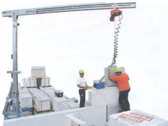
Diese Minikrane werden jetzt in feuerverzinkter Ausführung mit Hohlraumversiegelung geliefert.
