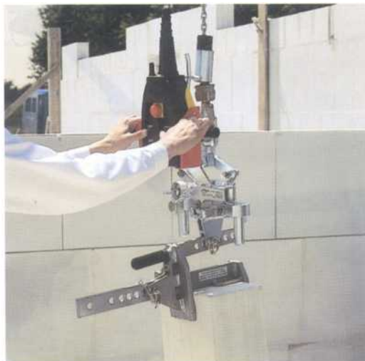
Diese Quadro-Zange hat eine Wechselvorrichtung für die Steinklammer.
