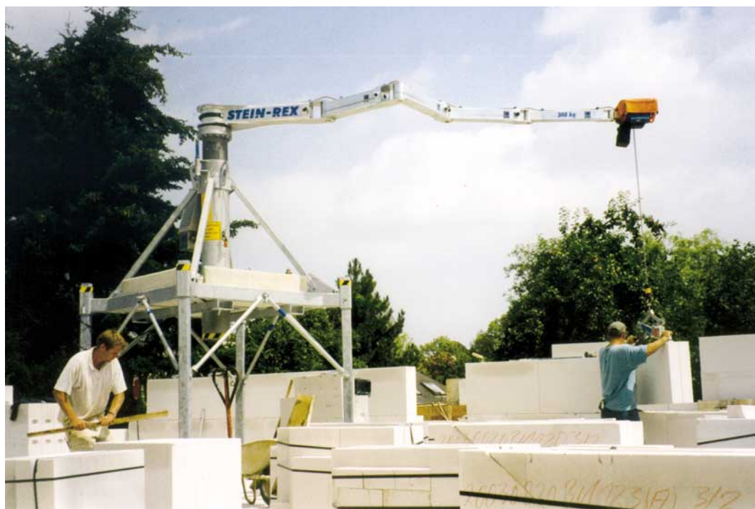
Hebegerät mit Gelenkausleger: Sind die Eckstützen ausgefahren, kann das Gerät über Steinstapel hinwegfahren.
