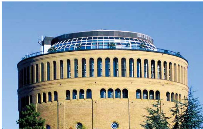
Oberhalb der Arkadenbögen des 9. und 10. OG thront als 11. Geschoss eine Pfosten-Riegel-Konstruktion aus wärmedämmten Aluminiumprofilen und Isolierglas; darin beheimatet: das seit Ende 2003 mit einem Michelin-Stern ausgezeichnete Restaurant »La Vision«.
