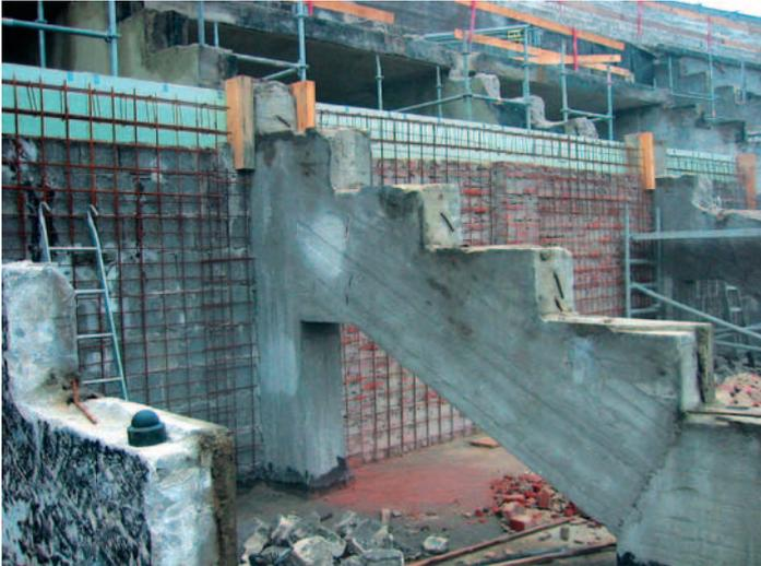
Olympiastadion Berlin: Bestehende, nicht mehr standfeste Wandscheiben aus Mauerwerk oder Stahlbeton werden im Rahmen einer Betoninstandsetzung durch bewehrte Spritzbetonschalen verstärkt.
