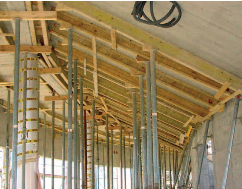
Innenansicht des Rundbaus mit Unterstützungen für die Montage- und Betonierphase der Tribüne
